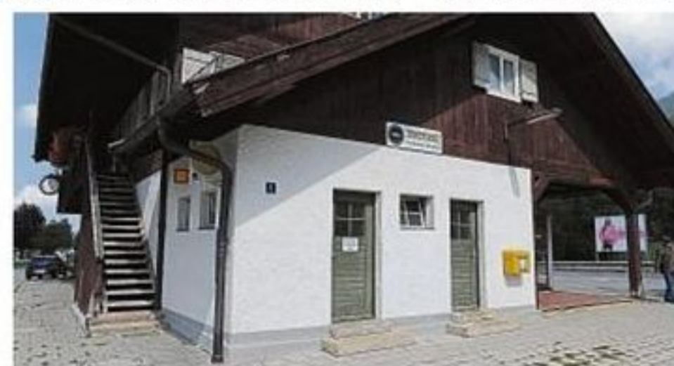
Bis Weihnachten saniert: Sobald die Skisaison richtig losgeht, sollen die Toiletten rundum erneuert sein. FOTO: ARCHIV AL
