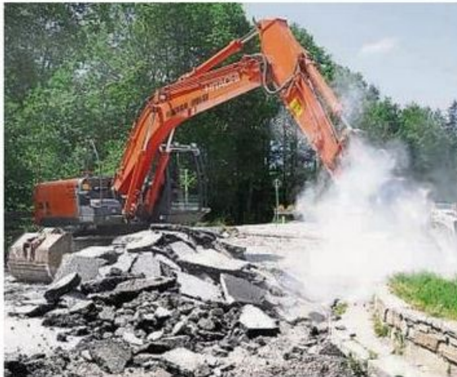
In die Jahre gekommen ist die Brücke über den Pfarrbach bei Bayrischzell. Sie wird deshalb abgerissen. FOTO: ANDREAS LEDER
